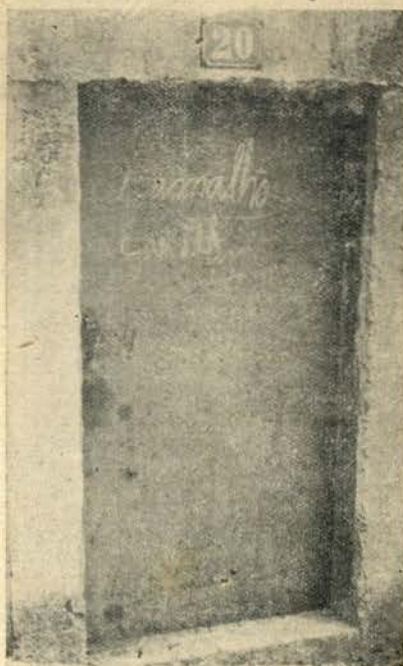
O n.º 20 da Calçada da Glória, que dá passagem para o túnel
