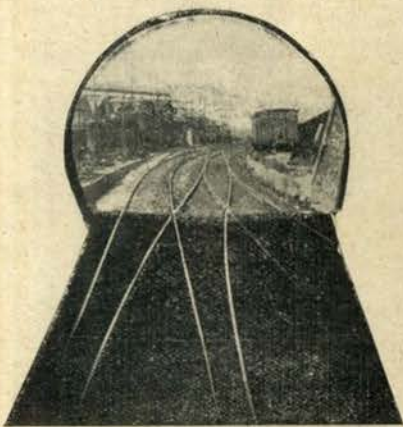
A embocadura do túnel, do lado de Campolide
