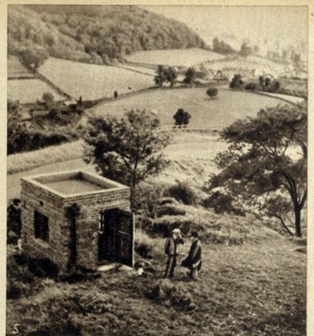
5—Junto do reservatório que fica acima da cidade vê-se a instalação da aparelhagem para misturar cloro na água
