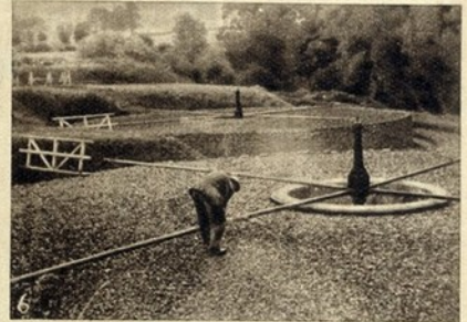
6—É uma instalação de filtragem bem montada que foi instalada a expensas da própria cidade
