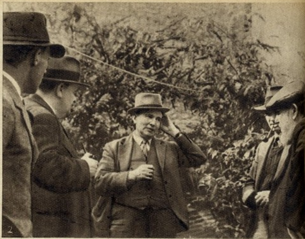
2 — Entupiu-se e está a transbordar um cano de esgôto, junto da igreja Baptista. O encarregado da secretaria da junta, do distrito rural, o inspector e outras autoridades reünem-se para o inspecionar
