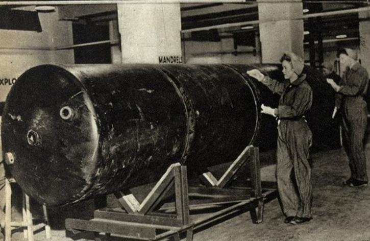
O envoltório do formidável cilindro, depois de esmerilhado, vai ser carregado de metralha
