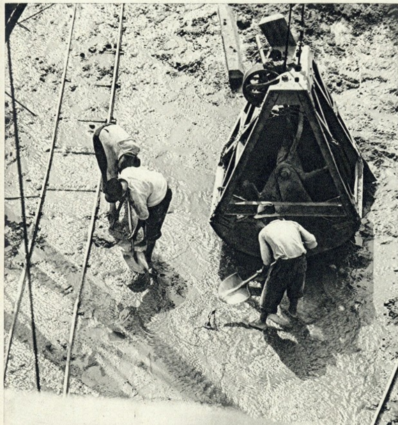
A água, por vezes, inunda os trabalhos e, misturando-se com a terra sob o fulgor ardente do sol, parece prata lavrada. O veio perdido é logo estancado
