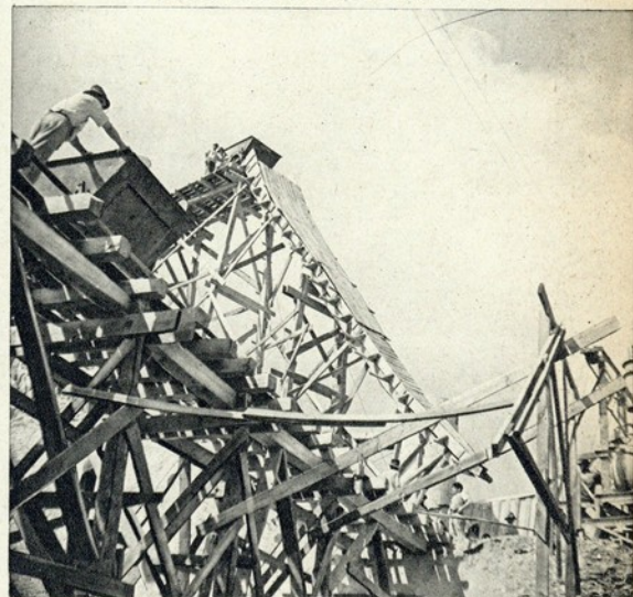
Estes esqueletos de madeira são transportadores de cimento que deixam cair a massa em fusão nos fundamentos da obra
