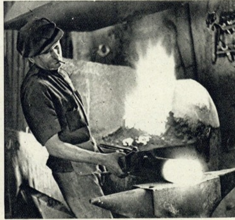
O aço em brasa sai da forja agarrado pelas tenazes vigorosas do operário
