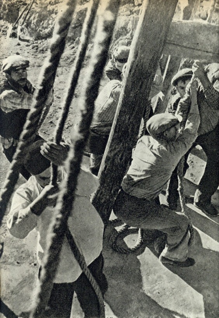
Na planície enorme, os trabalhos desenvolvem-se grandiosamente. Abrem-se já as fundações para a gare aérea
