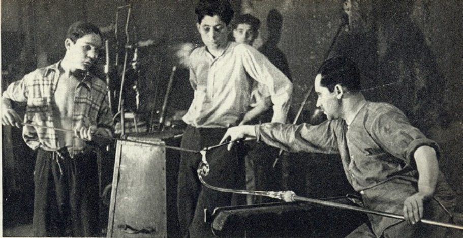
O aprendiz dá a «marisa» ao oficial para acabamento da obra. O vidro em fusão «cola» facilmente
