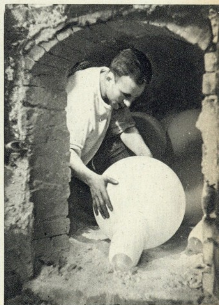
Aqui é a «arca» onde se temperam as peças. O operário desenforma
