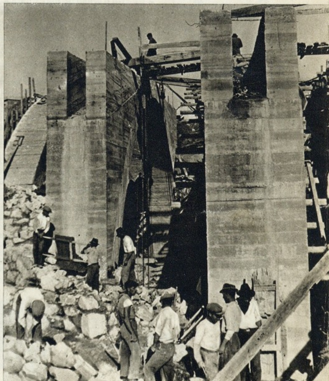
Os arcos, já delineados na sua estrutura de cimento, a sua robusta construção
