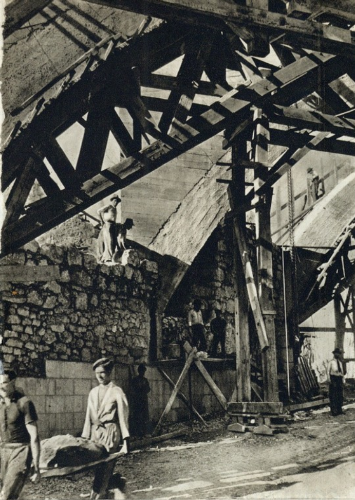
Uma das voltas da ponte da rua do Arco de Carvalhão
