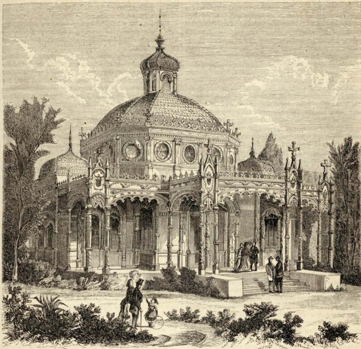
Pavilhão portuguez, na exposição universal de Paris, construído segundo os desenhos do architecto mr. Rampin Mayor
