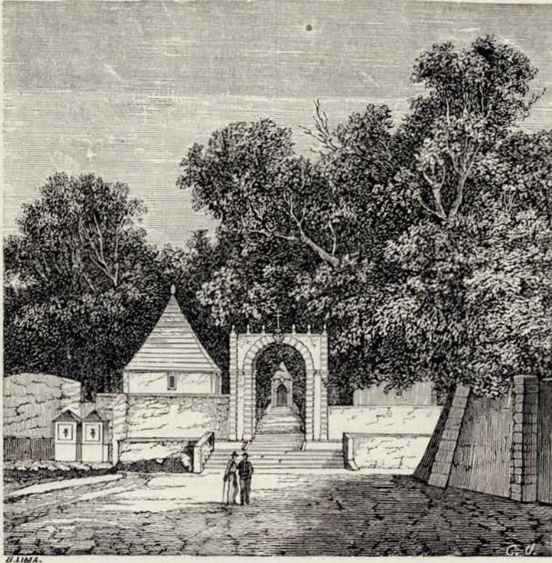
Portico da entrada do sanctuario do Bom Jesus do Monte
