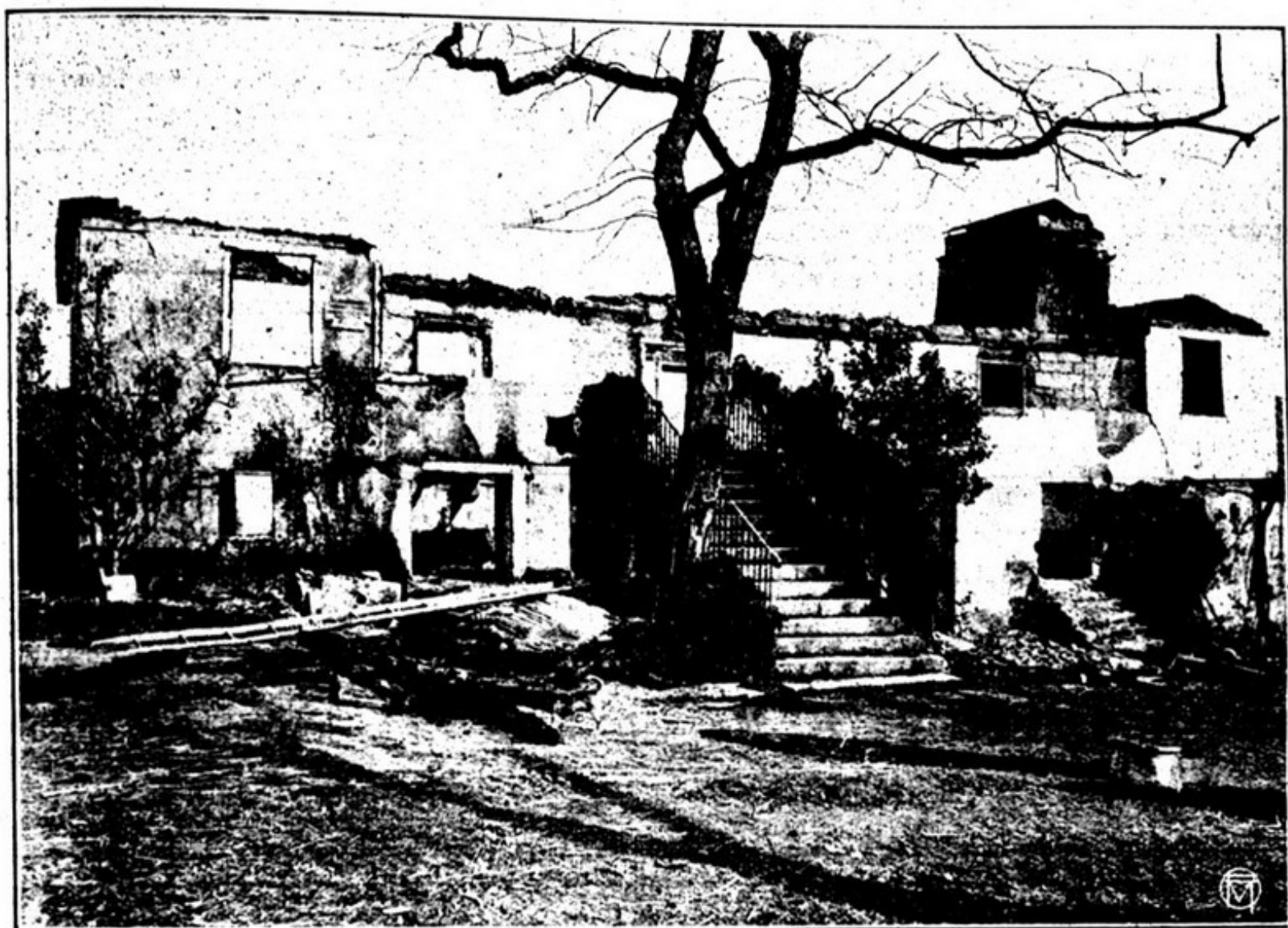
DEPOIS DO INCENDIO — ASPECTO DAS TRAZEIRAS DA CASA
