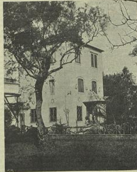
FACHADA DO SUL
