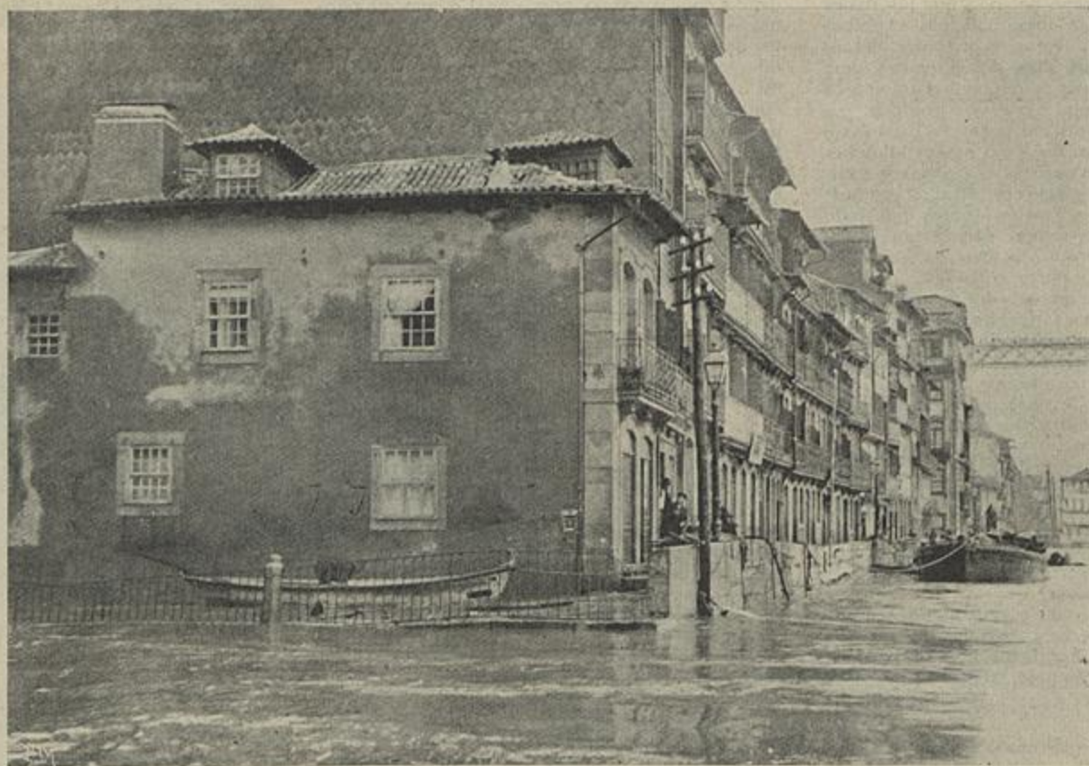
NO PORTO, A INUNDAÇÃO NO MURO BACALHOEIRO
