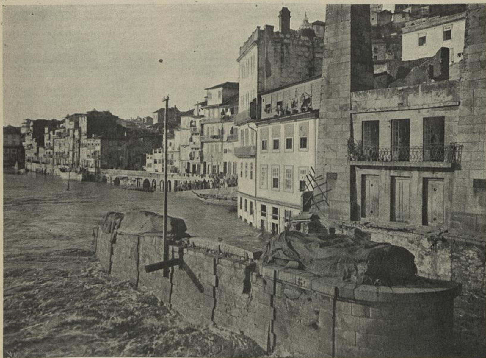
NO PORTO, A INUNDAÇÃO NO SITIO DA ANTIGA PONTE PENSI. (De fotografias)
