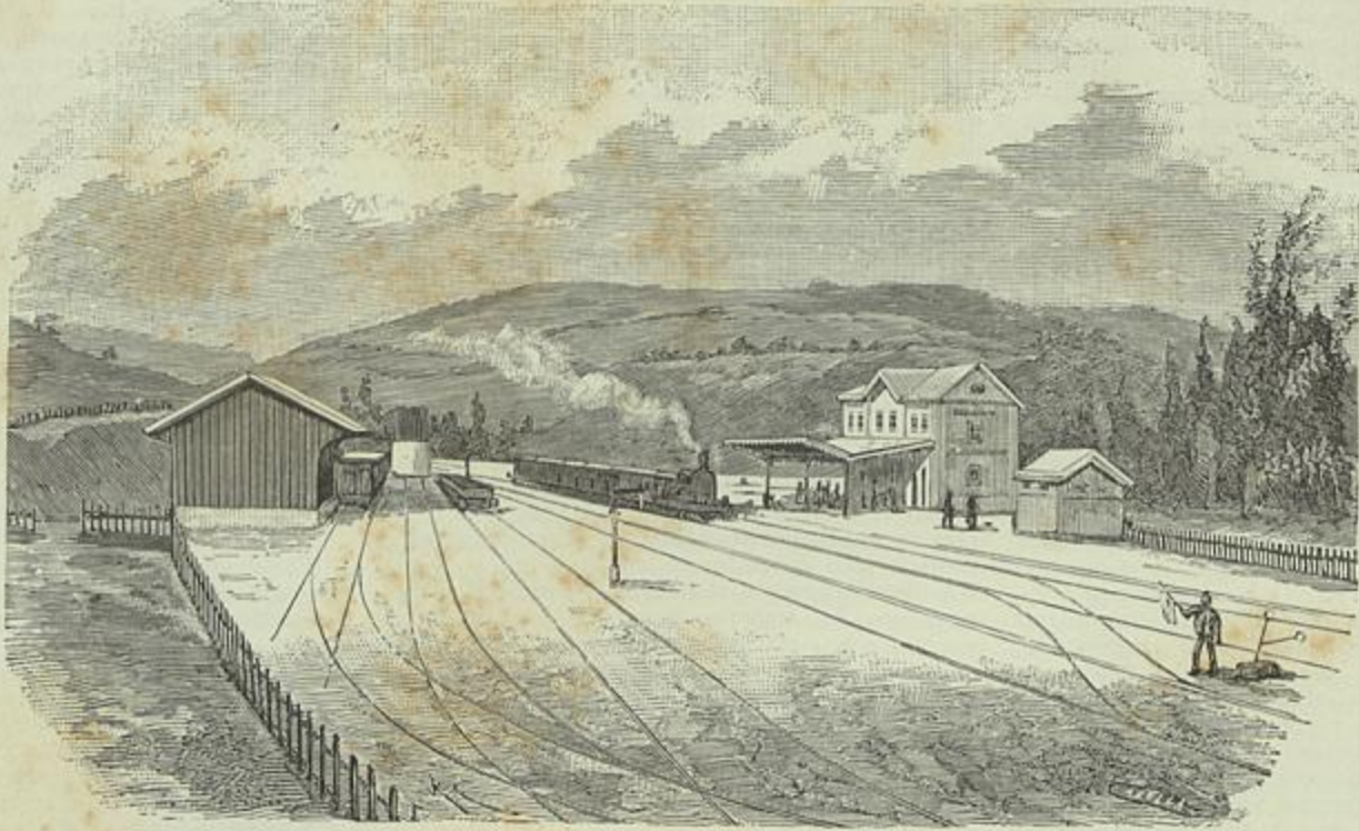
CAMINHO DE FERRO DE TORRES VEDRAS — ESTAÇÃO DE DOIS PORTOS
