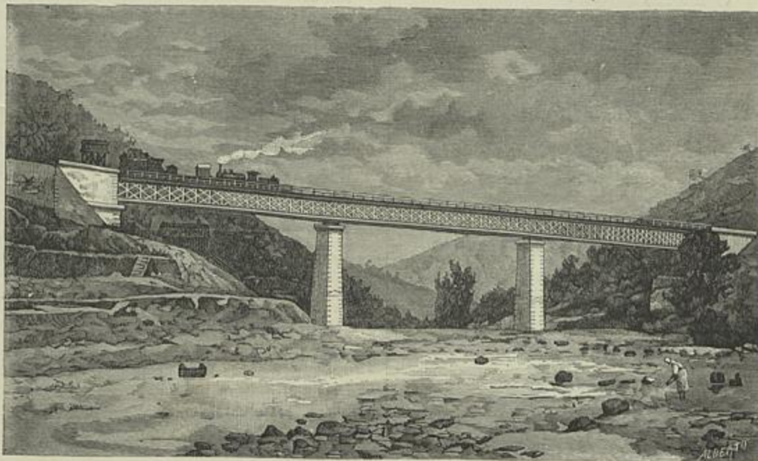
CAMINHOS DE FERRO PORTUGUEZES — VIADUCTO DO CORGO, NO CAMINHO DE FERRO DO DOURO
