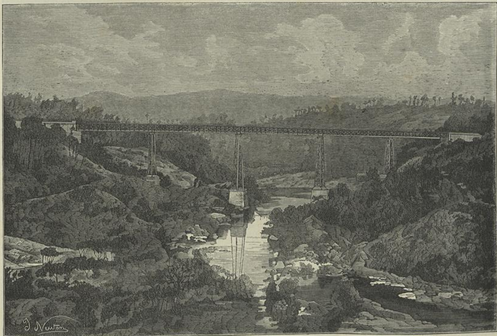
CAMINHOS DE FERRO PORTUGUEZES — PONTE SOBRE O TAMEGA, NO CAMINHO DE FERRO DO DOURO (Segundo uma photographia de Biel)
