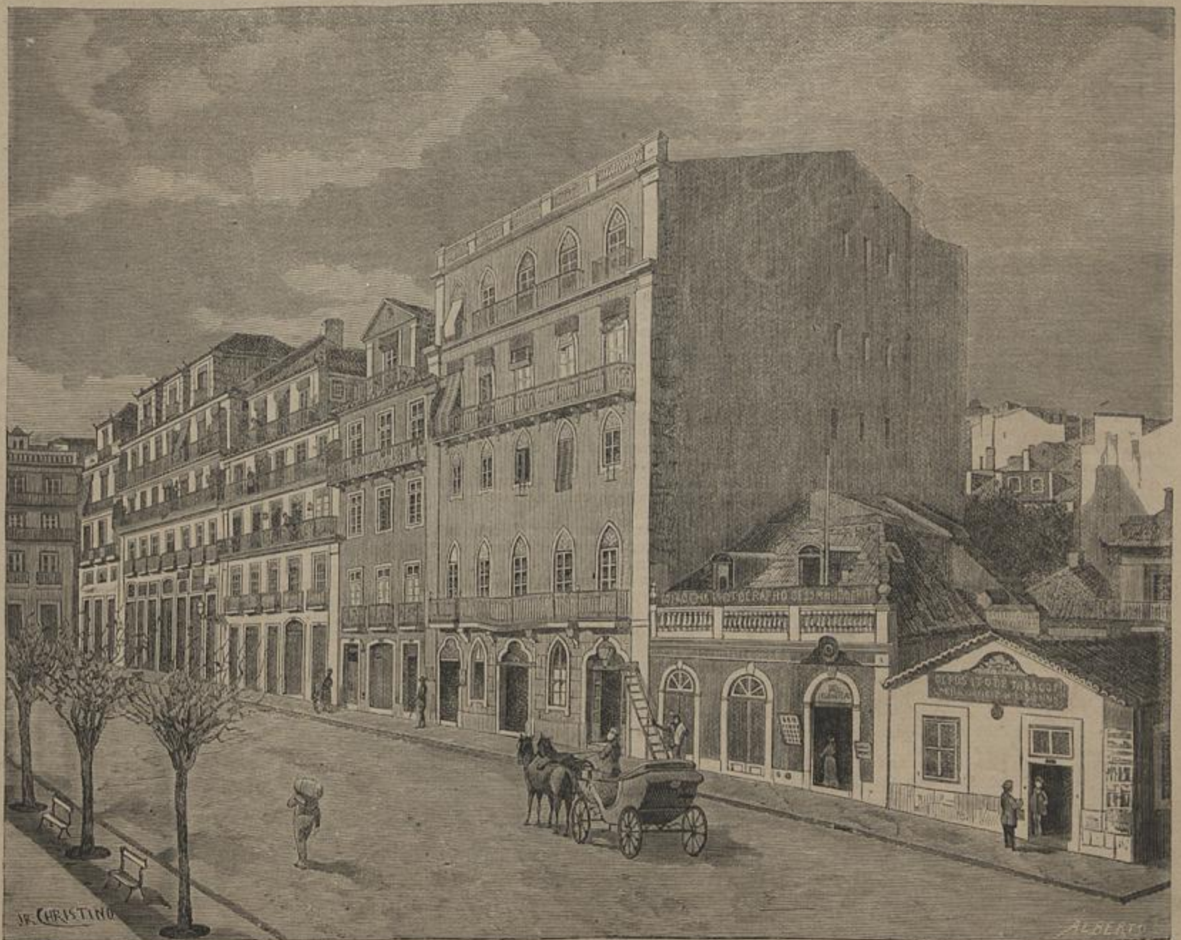
MELHORAMENTOS DE LISBOA. — AVENIDA DA LIBERDADE, PRAÇA DA ALEGRIA DE BAIXO, PREDIOS DEMOLIDOS. (Segundo uma photographia de Rocha.)
