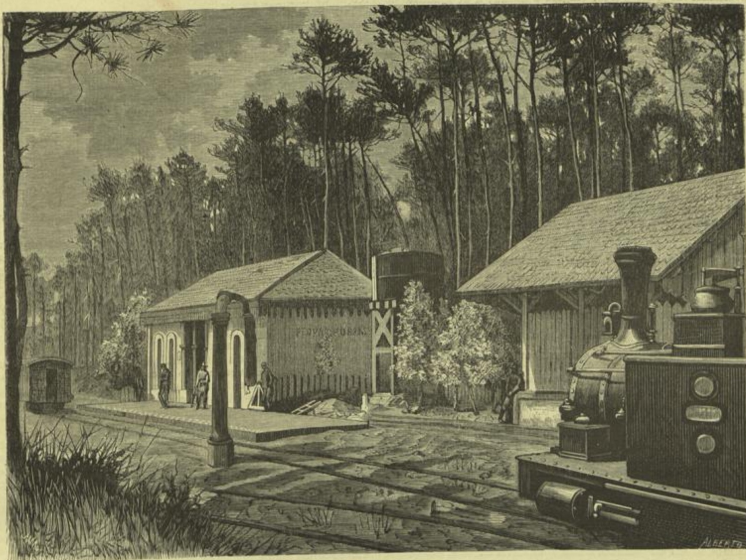
ESTAÇÃO DE PEDRAS RUBRAS NO CAMINHO DE FERRO DO PORTO À POVOA DE VARZIM (Segundo uma photographia do sr. P. Rochini)
