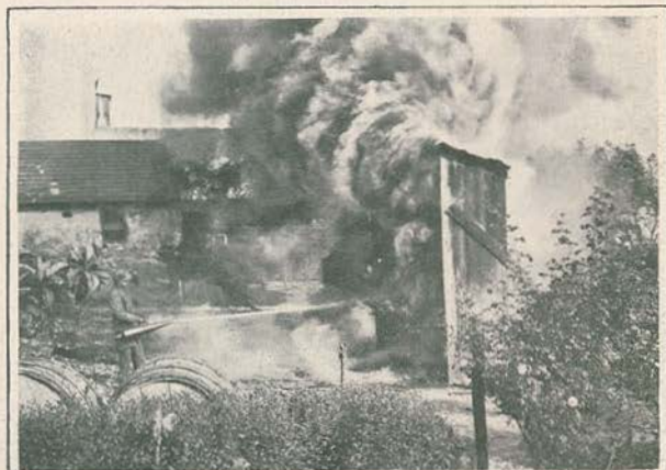
Aspéto das experiencias do extintor d'incendios Minimax cujos resultados foram surpreendentes.—(Tíché de Beaudet)
