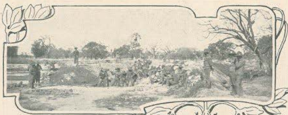
Trabalhos de construção do forte D. Luiz de Bragança
