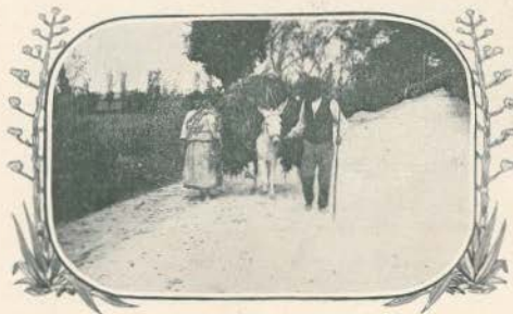
Na estrada de Coimbra á Figueira
