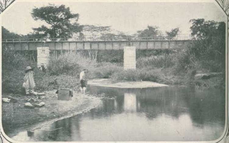
Um viaducto no Valle do Zombo —Ponte do Luinha
