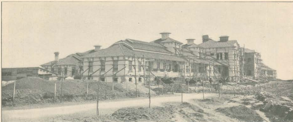
O NOVO SANATORIO DA PAREDE
