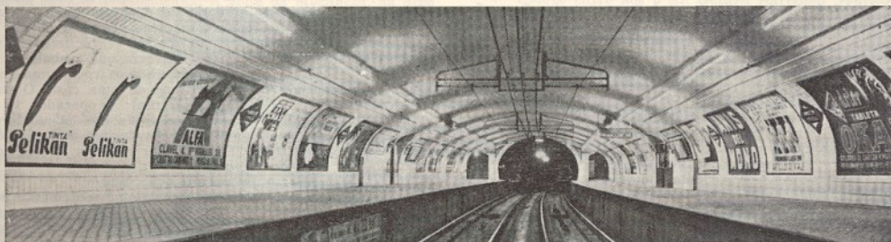
Interior de uma estação do «Metro»
