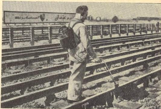
A London Transport experimentou, com êxito, um aparelho, de invenção recente, que se destina a descobrir, por meio do som, as fendas que se produzem nos carris.
