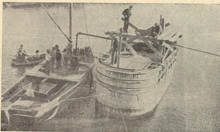
Colocação de um caixão de fundação dos pilares na Ponte de Alcácer do Sal
