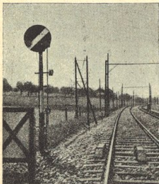
Figura 1—Eléctro-íman da via ao sinal a distância, mostrando o contacto acionado pelo disco de sinalização.
