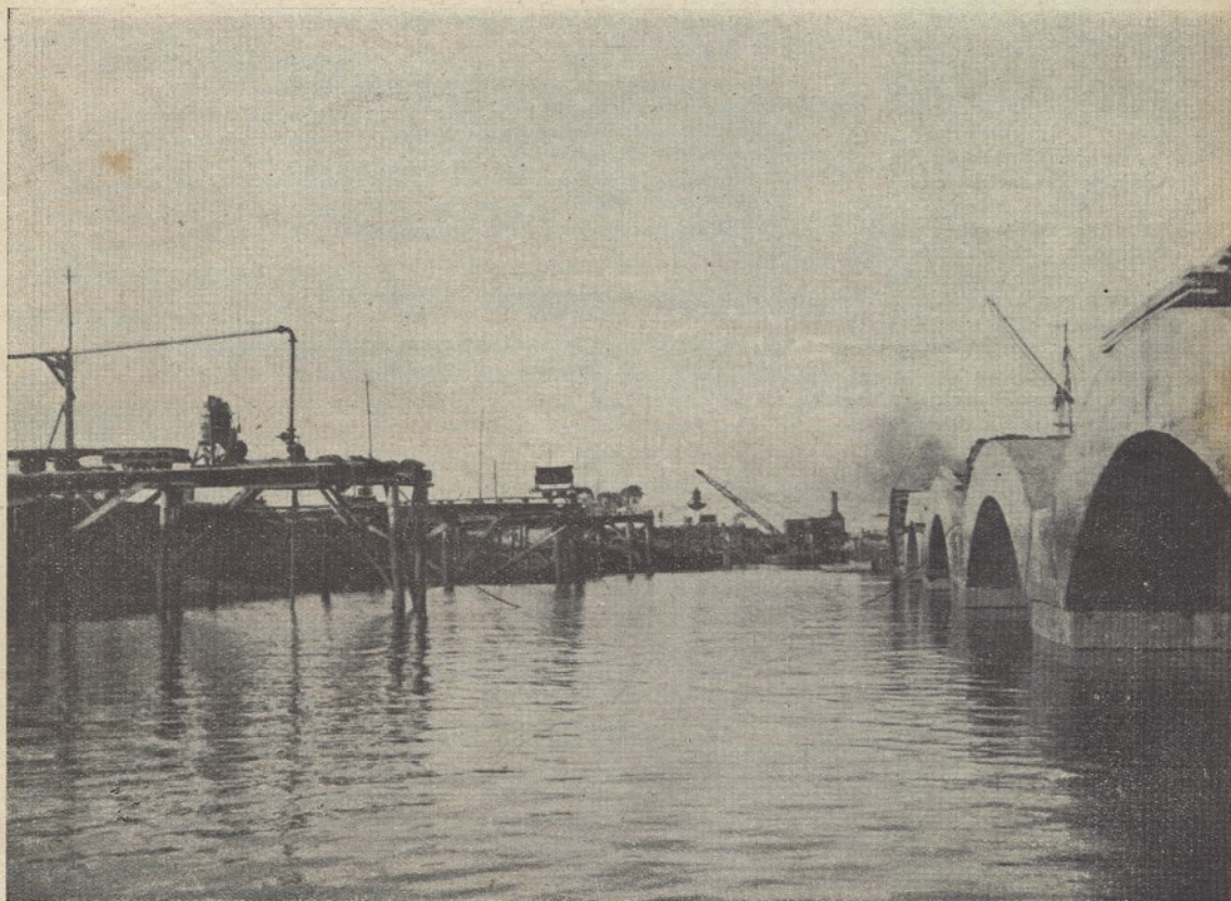
VISTA DAS ABOBADAS DO MURO DO CAIS, DO LADO DO ATERRO
