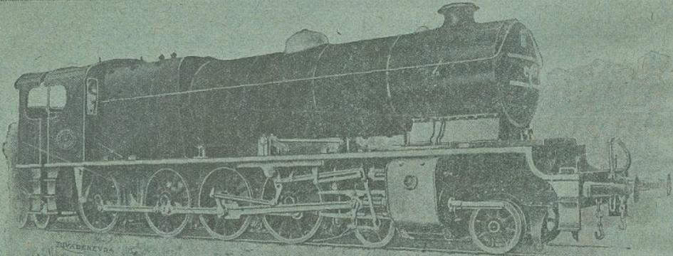
Typo de locomotiva «Mastodonte» de grande potencia, tres cylindros e simples expansão, construída expres-
