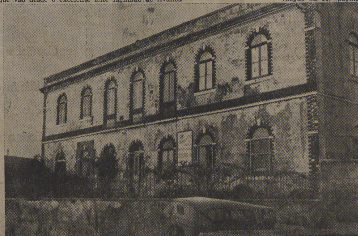
O belo edificio do Posto de Puericultura n.º 4 no Lumiar
