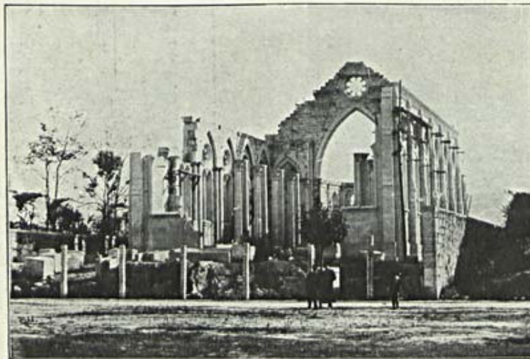
Fafe. — Igreja em construção
