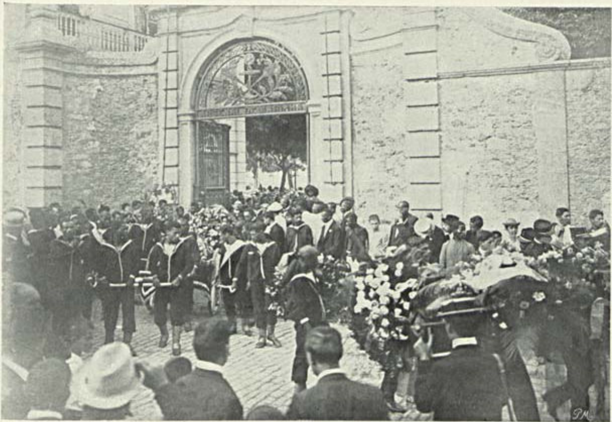
No Rio de Janeiro. — Trasladação dos restos mortaes dos almirantes Barroso e Saldanha. — Sahindo do Arsenal de Marinha.
