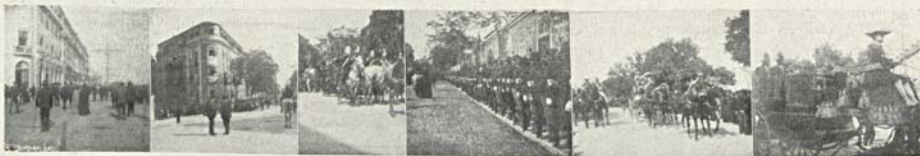
Aspectos da Rua 24 de Julho e da Avenida D. Carlos
