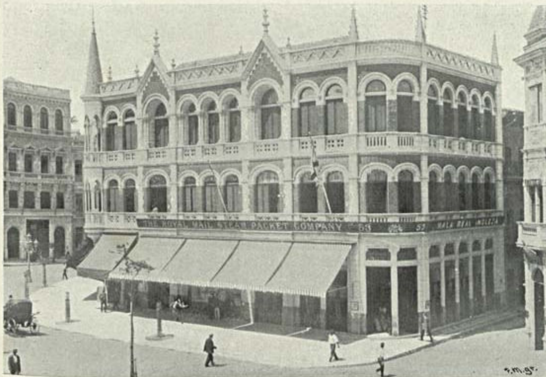
Mala Real Ingleza. — Edificio da agencia no Rio de Janeiro
