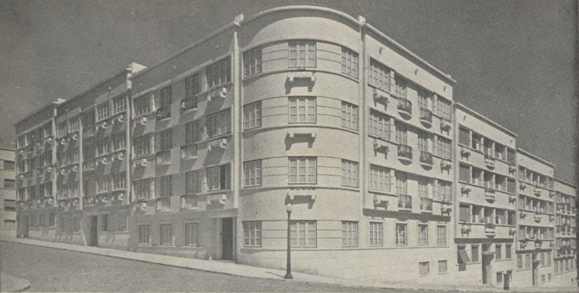
ALGUNS BLOCOS DE CONSTRUÇÕES RECENTEMENTE CONSTRUÍDOS
