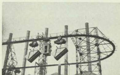
AMSTERDÃO — Mono-rail para transporte dos lixos dos batelões para a incineradora
