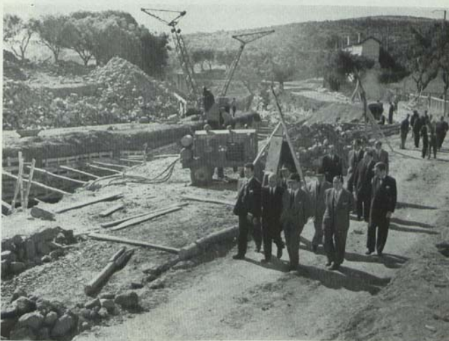
VISITA DA PRESIDENCIA E VERAÇÃO A OBRAS MUNICIPAIS (CANEIRO DE ALCANTARA)
