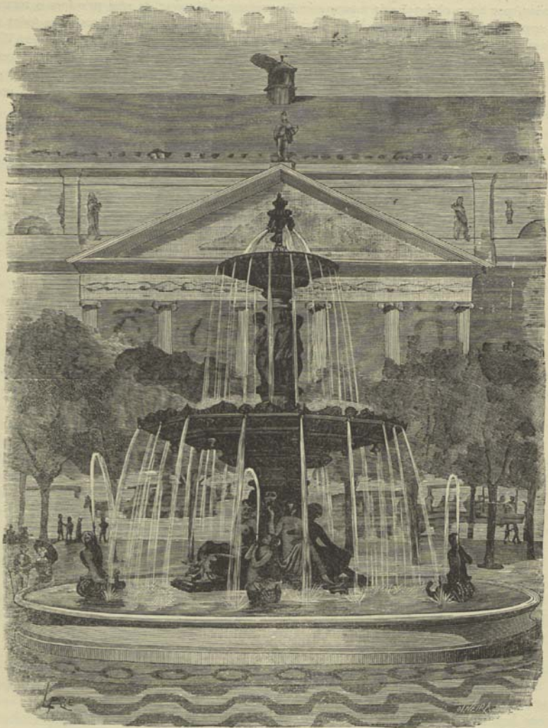
MELHORAMENTOS DE LISBOA FONTE MONUMENTAL EM CONSTRUÇÃO NO ROSSIO (DESENHO DE L. FREIRE)
