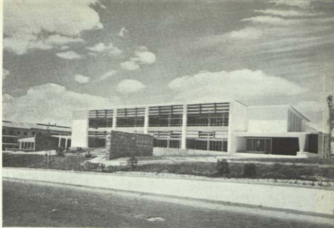
GRUPO ESCOLAR DA CÉLULA VII — ALVALADE — BAIRRO DE S. MIGUEL — FACHADA DAS AULAS
