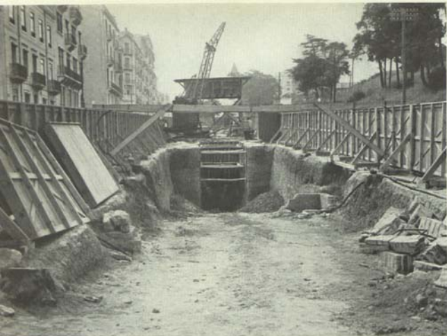
INÍCIO DAS OBRAS DO METROPOLITANO DE LISBOA
