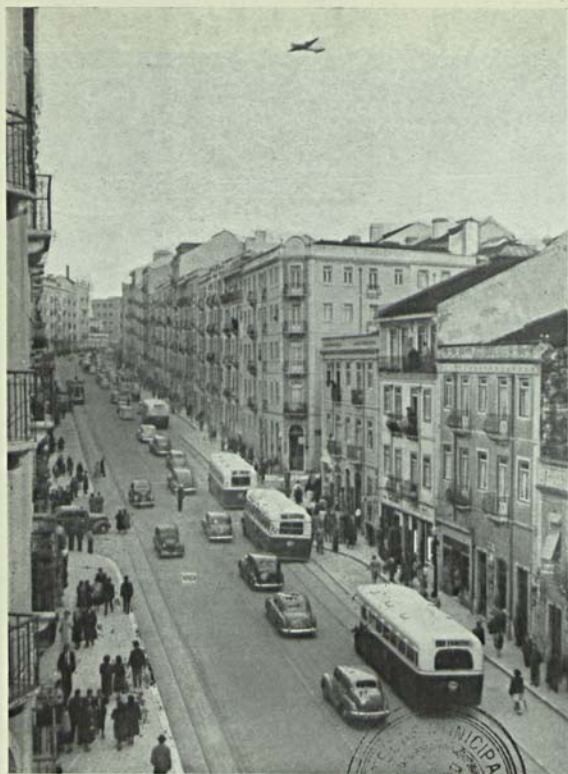
A RUA MORAIS SOARES, DEPOIS DAS OBRAS DA NOVA PAVIMENTAÇÃO
