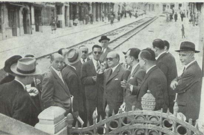
O PRESIDENTE DA CAMARA E VEREADORES VISITAM AS OBRAS DA CIDADE
