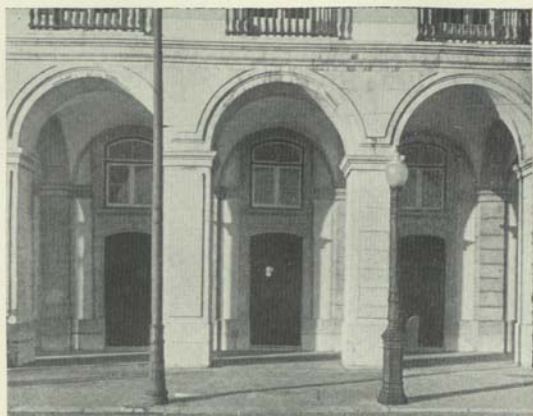
Tampão do poço sulfídrico junto do 6.º arco das arcadas ocidentais do Terreiro do Paço
