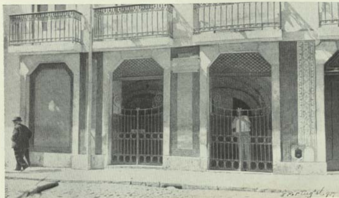
Aspecto exterior do actual Poço do Borratêm
