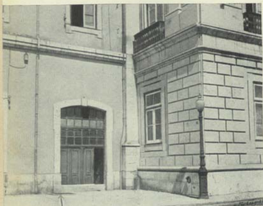
Casa das máquinas onde é aspirada a água sulfídrica do poço junto da porta de entrada
