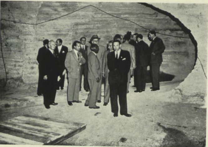
Visita às obras de Regularização da Ribeira de Alcântara
