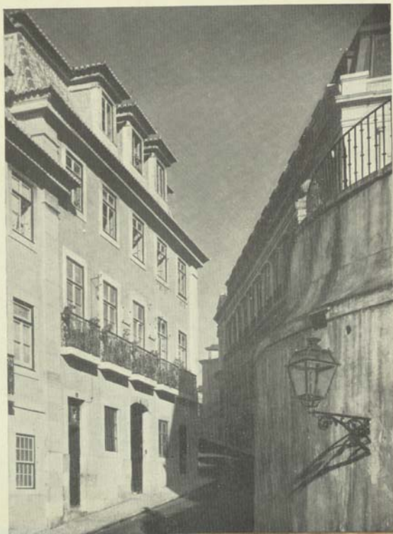
NESTE PRÉDIO DA CALCADA DOS CAETANOS FALECEU RAMALHO ORTIGÃO
