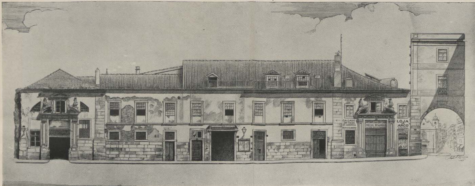
Fachada sul do Palácio do Marquês de Alegrete
