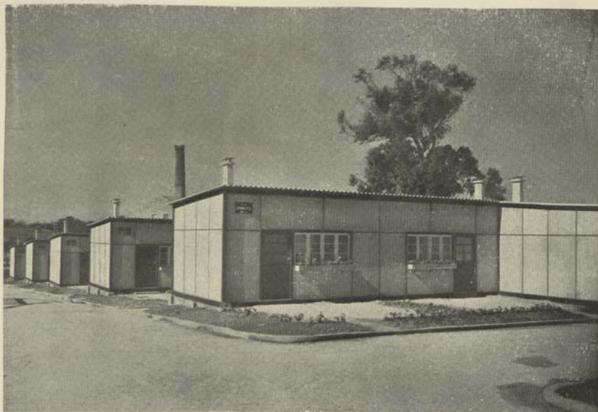
Trecho do Bairro Popular da Quinta da Calçada, inteiramente construído em LUSALITE e que constitui uma honrosa realização da Câmara Municipal de Lisboa
