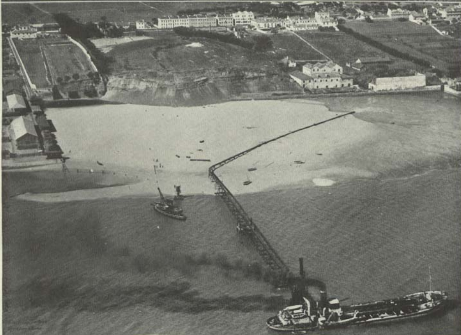
Em cima: — O grande atêro da Matinha é construído activamente, com areia da outra margem e com o desmonte de um cêrro. Em baixo: — Fotografia aérea (tirada no mesmo momento) vendo-se, à lente, a mesma fila de homens que despejam terra.
