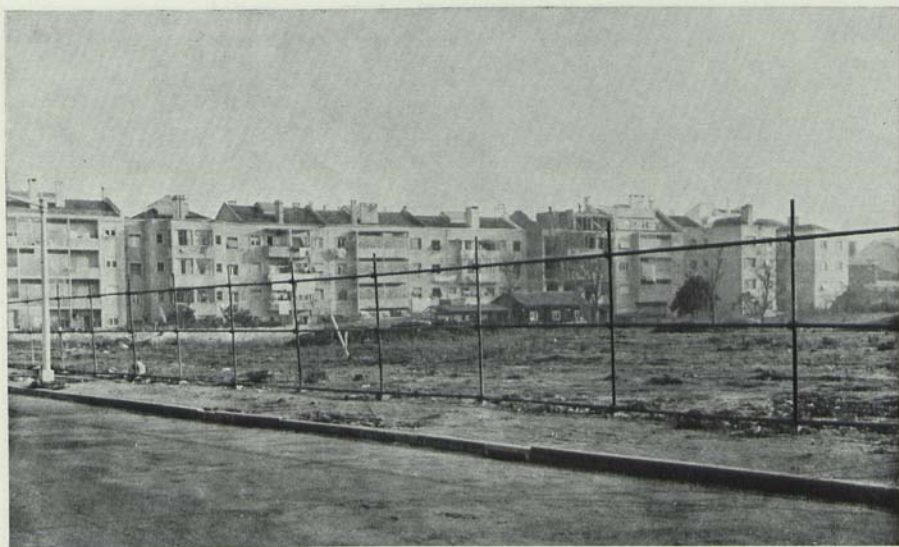
Futuro mercado da Casquilha, a construir na extensa área de terreno que se mostra vedado com redne e corresponde à dimensão linear da Rua Emilia das Neves, Rua João Frederico Ludovice, desde os n.ºs de policia 2-2-B e 2-C até aos n.ºs 12 e 12-D da mesma rua, a uma zona de terreno que medeia entre a vedação e o Bairro de Santa Cruz e, por último, à Avenida Grão Vasco, parcialmente, como bem se prevê
