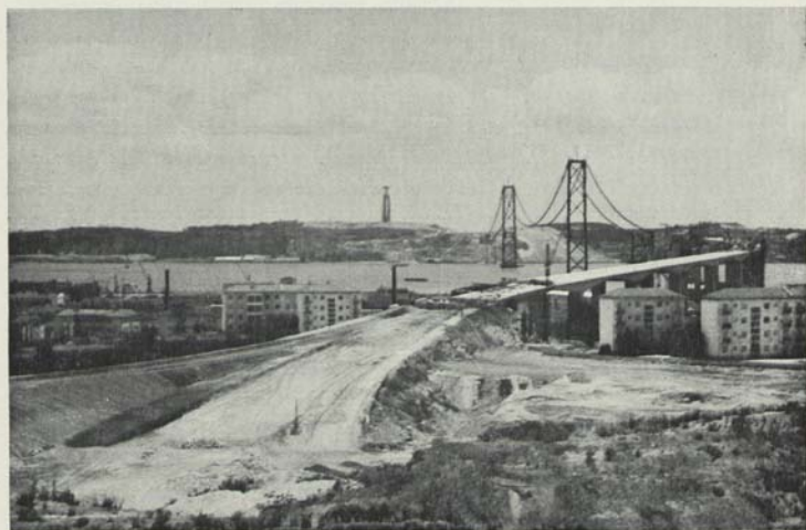
Aspecto actual da zona edificada e de construções clandestinas que de tal modo houve de transformar-se atendendo à necessidade de acessos à ponte Salazar, com benefícios para a salubridade e higiene do mesmo local
