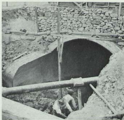
Troço do Caneiro de Alcântara, em construção, junto da Av. Grão Vasco, a poucos metros da entrada principal do Parque Silva Porto e do mercado de Benfica. Permite apreciar as dimensões da secção do Caneiro se forem tomadas para termo comparativo as estaturas dos operários assinalados na gravura
