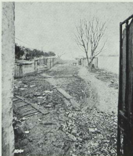
Aspecto actual da extensão de terreno que ocupa o local onde algum tempo antes existiu a vala de esgoto
