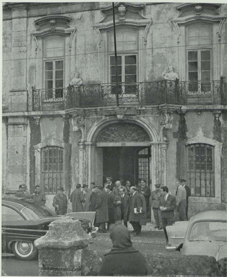
VISITA DA NOVA VEREAÇÃO AO PALACIO DO PIMENTA, EM PROSEGUI- MENTO DA SERIE DE VISITAS A OBRAS EM CURSO
