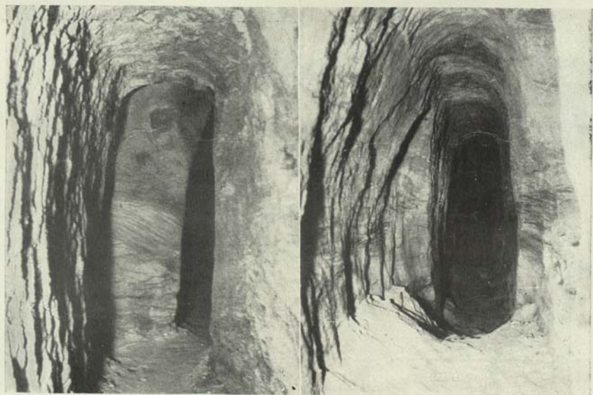
EM CIMA — FRENTE DE DESMONTE COM A ENTRADA DE DUAS GALERIAS EM BAIXO — ASPECTO INTERIOR DE DUAS GALERIAS
