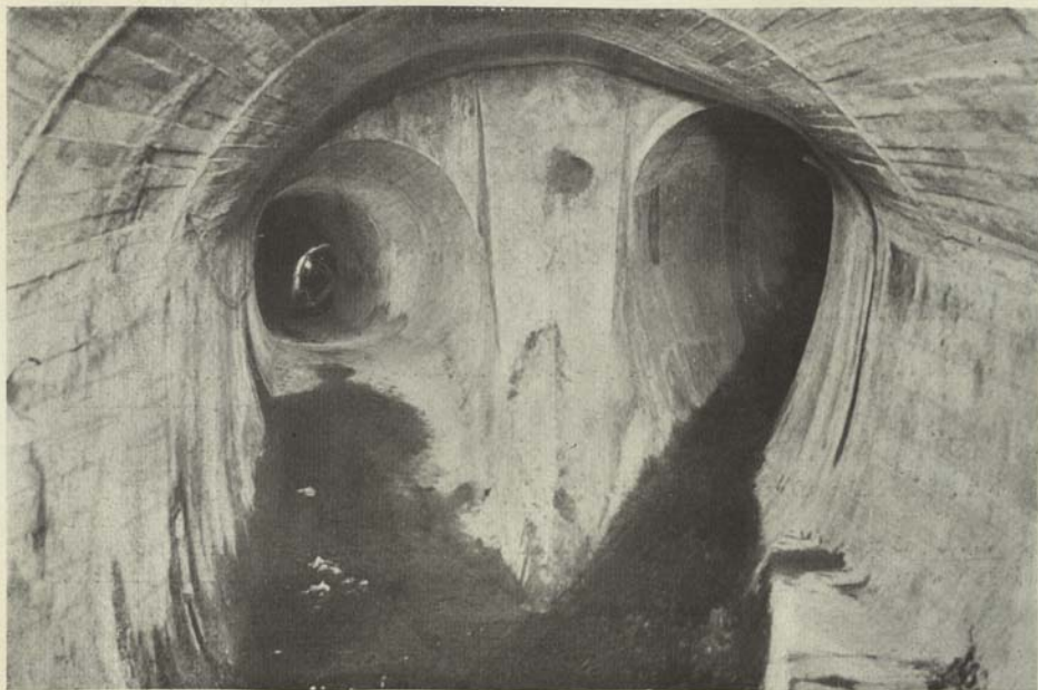
A JUNÇÃO DO VELHO COLECTOR DE ALMIRANTE REIS (A DIREITA) COM O NOVO COLECTOR DO REGUEIRÃO
