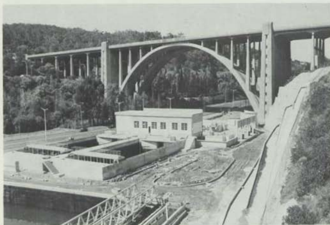
Vista da Estação de Tratamento de Águas Residuais de Alcântara, em construção.
