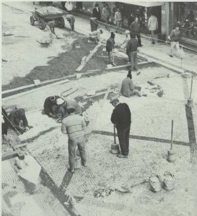
Calçada tradicional portuguesa na Rua Augusta – aspecto dos trabalhos.
